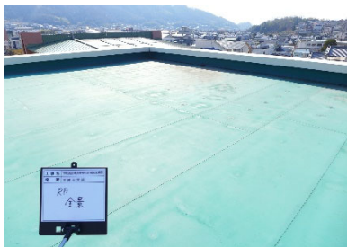
屋上 防水状況
