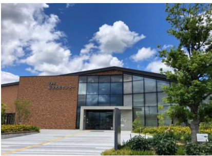
総合文化センター外観(入口右：図書館)
