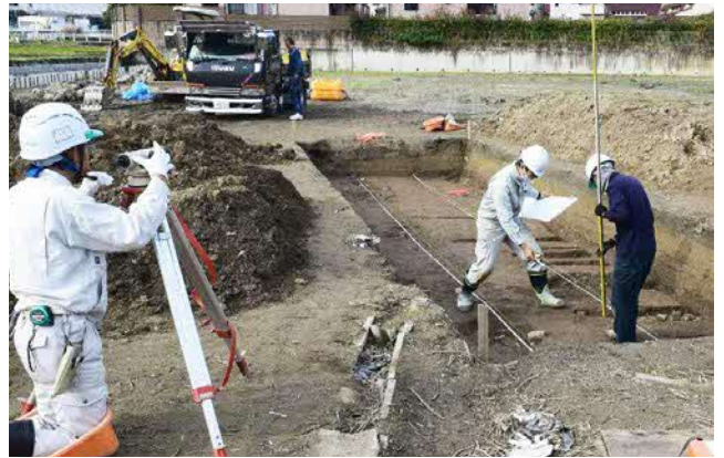
▲調査区の遺構を測量（令和3年度・若井西宮遺跡）
