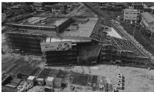
敷地南東側からの工事写真 (令和元年8月時点)
