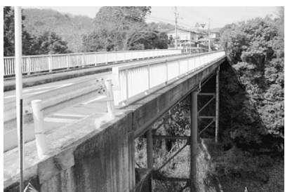
若葉大橋架橋後29年経過
