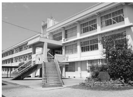
太陽光パネルを設置する平群中学校
