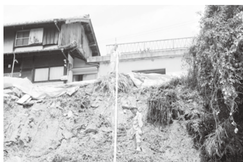
集中豪雨で道路が崩壊した現場
