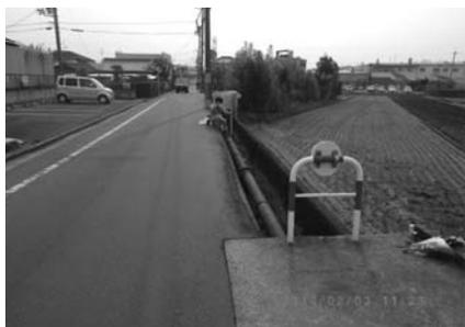
町道の路面補修等によって、道路面と路肩に段差があるため、実際、人や車が通れる道路幅員が狭くなっており、歩行者が車を避け、運転者は歩行者を避けなければならぬので、非常に危険な道路になっている。道路端の段差が原因が判らないが、今年の1月29日午後9時過ぎ、町道川原路線の側溝に転落し
