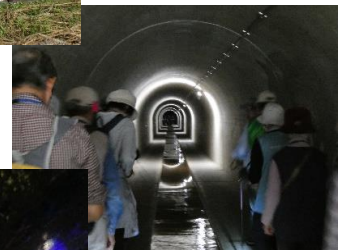
第一排水トンネルの見学 長さ約2km、通路の中央 に水が流れる水路が あり、トンネル内は年中 15℃前後と夏は涼しい
