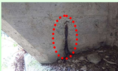
主桁の損傷（鉄筋露出）
