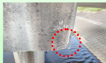
橋脚の損傷（剥離）
